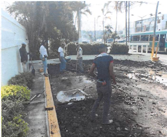
CONSTRUCCIÓN GRAMPINE EDIFICIO 1
